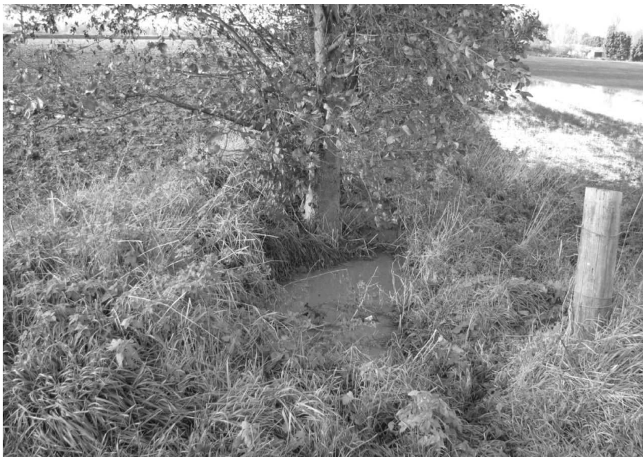
Winter 2011. Westzijde van de Lange Dijk in het oude stroomdal van de Aa-Strang I. Onder: Het slootje beneden is bij lange na niet in staat om het water van de andere kant van de Lange Dijk (o.a. middels duiker) richting de Theetuin af te voeren.
