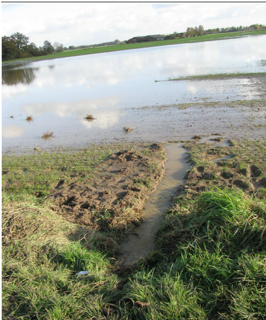
Watermassa aan de zuidzijde van de Lange Dijk, in het oude stroomdal van de Aa-Strang I, winter 2011. De fotograaf bevindt zich bovenop de duiker in de Lange Dijk. Het gootje op de voorgrond en de duiker zijn ontoereikend om het water in de richting van de Theetuin af te voeren.
