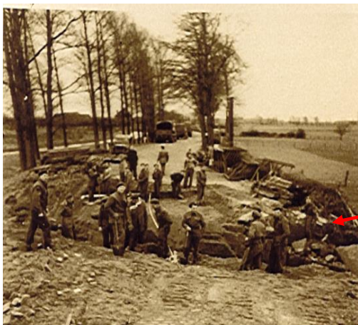
Herstel van de brug
